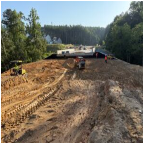
Fill placement area
