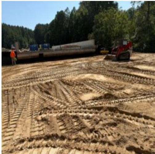
Fill Placement area
