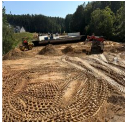
Fill placement area
