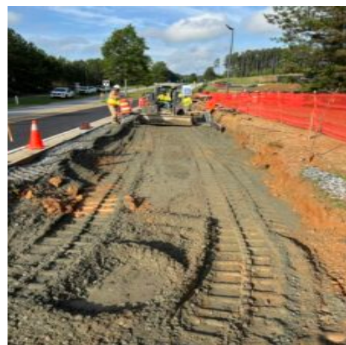
Preparations for curb pour
