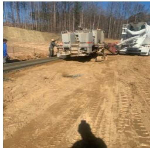
24" curbing pour at phase 1B
