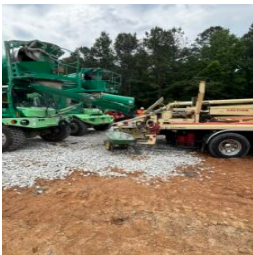
Concrete pour by pumping
