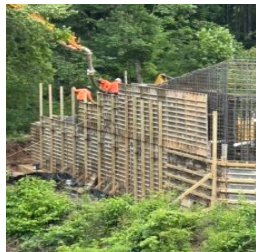
Wall pour at south side bridge
