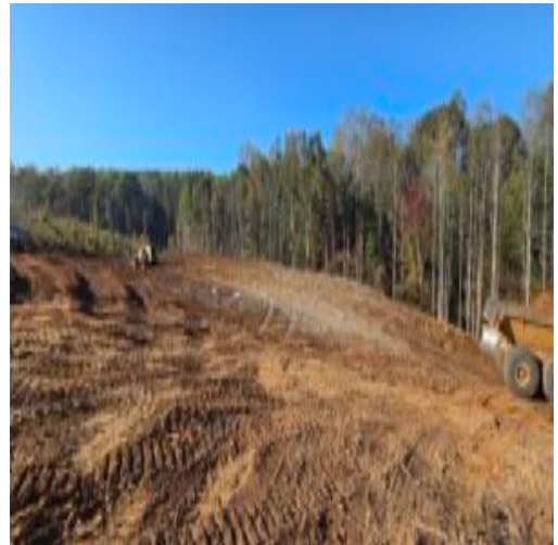
blasted rock fill
