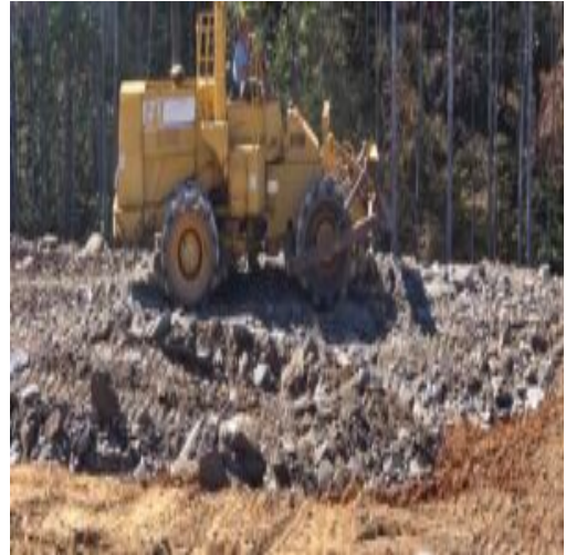
blasted fill material
