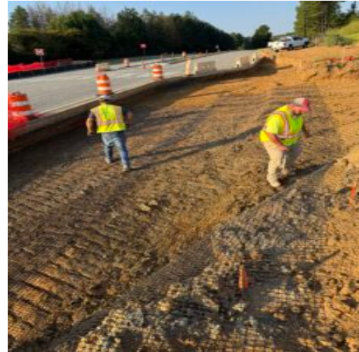
GEO grid placement
